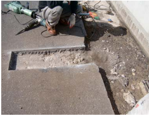
들뜸 아스팔트 제거 후 콘크리트 표면상태
