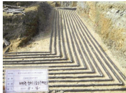
[그림 13] 트렌치 배관 작업
