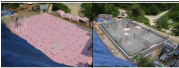
그림 10. 기초단열 및 콘크리트 타설
