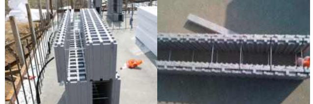
그림 8. 구조체에 적용된 외벽용(L)과 내벽용(R) 단열블럭
