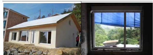
그림 13. Test-bed 측면도 및 창호 설치 작업
