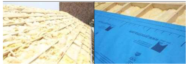
그림 12. 지붕 단열 및 투습방수지 설치
