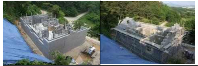
그림 11. 벽체조적 및 내부벽체 작업
