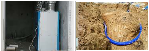
그림 14. 폐열회수 환기장치 및 쿨튜브 매설작업
