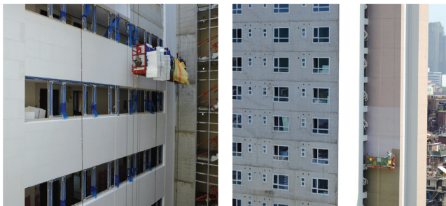
그림 4. 곤도라를 이용한 외단열 작업 모습
