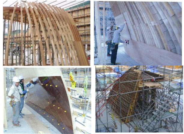
그림. 15 Rib 제작->합판취부 형틀 작업과정
