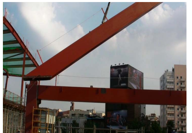
그림. 27 메가트러스 현장 설치 사진
