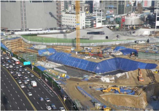
그림. 23 골조 현장 시공 사진
