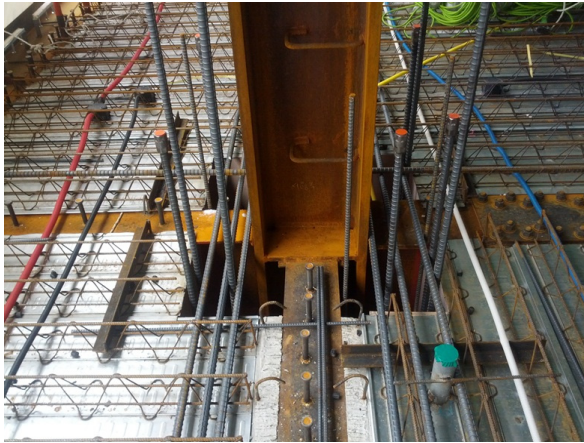
〈그림 8〉 보-기둥 접합부 시공사진
